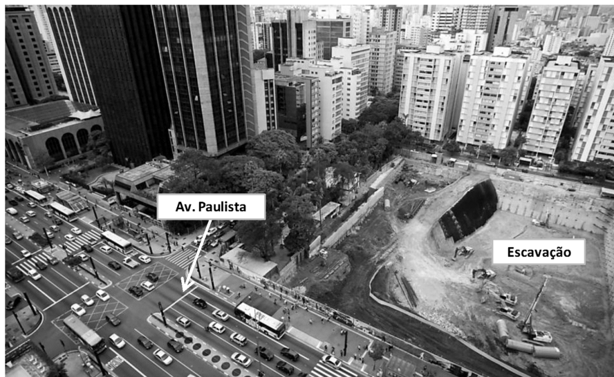
Figura 2. Execução de escavação
