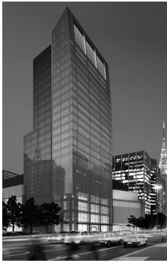
Figuras 1. Vista da futura Torre Matarazzo
